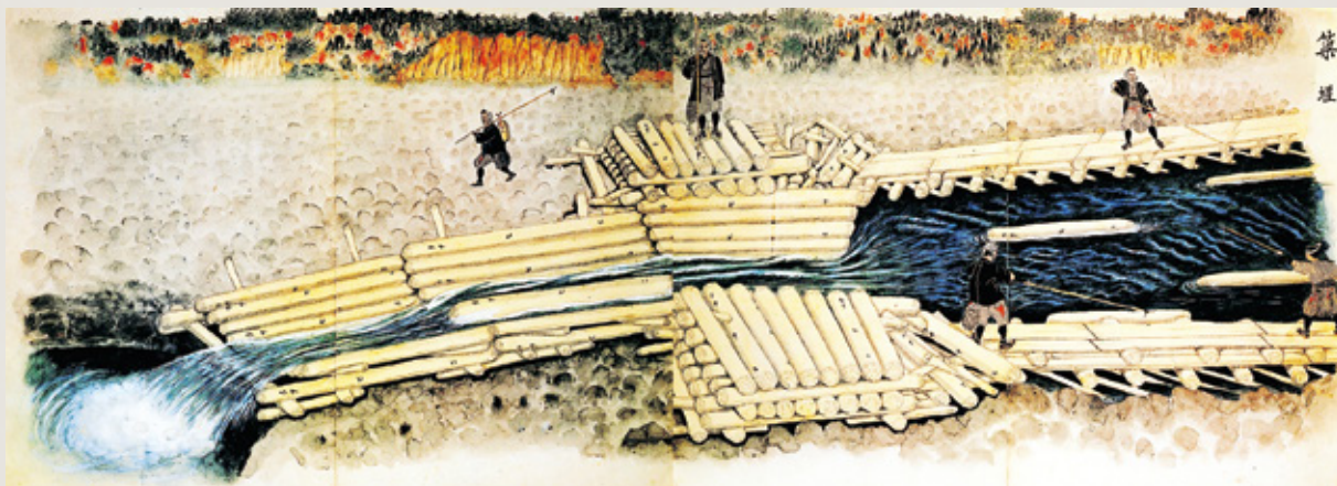
「付知川に於ける材木伐出の沿革と繪解」より「築堰」(丸太を水に浮かべて運ぶしかけの一つ)
