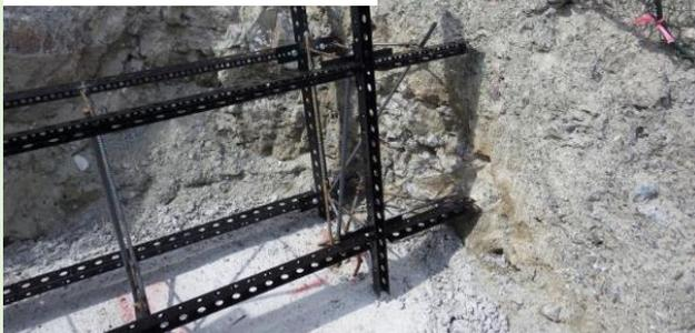
平割材型枠設置状況
