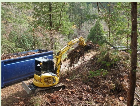
運搬車への積込み状況
