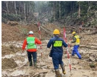
山地災害対策緊急展開チームの活動状況
