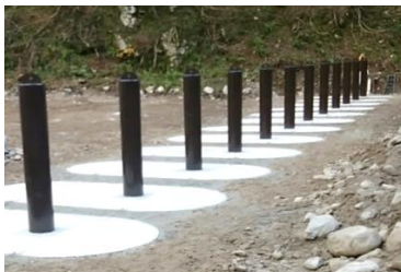
工事完成時(富山署)
