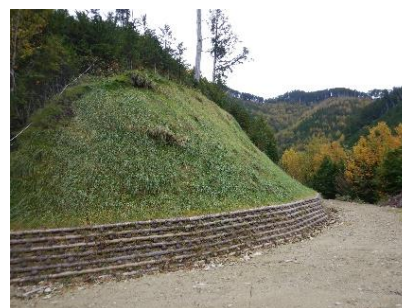
木製擁壁工(木曾署)
