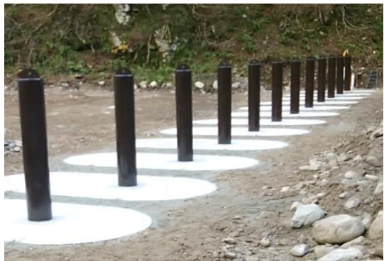
流木捕捉工（完成時）
