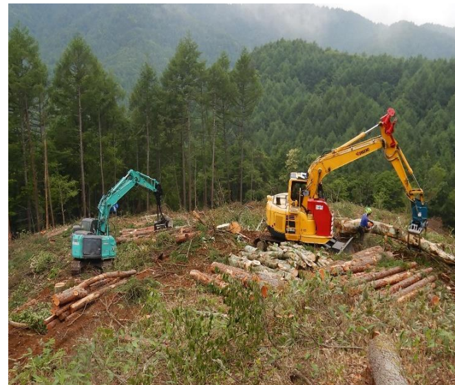
樹木採取権の設定を受けた 林業事業者による木材生産 (東信署)
