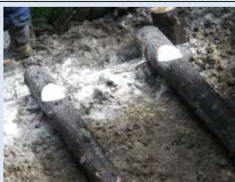
チェーンソーで切り込みを入れた仮留め
