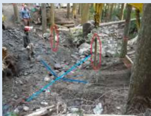
杭を打ち、進行方向と路面高を確認
