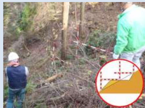
ポールを用いて、横断形を確認
