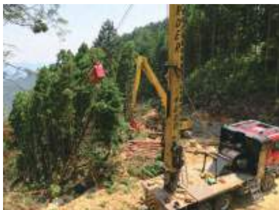
タワーヤードと高性能搬器による集材作業
