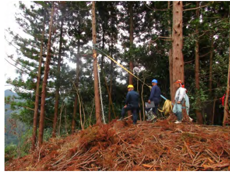
タワーヤーダによる集材現場の見学 (先柱作設状況)
