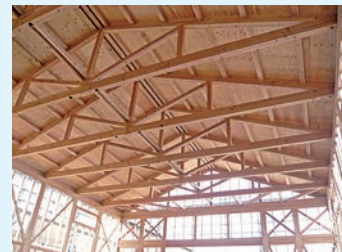
写真8-3 一般流通材を用いた低コストトラス
