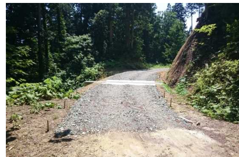
入込山国有林 (ガベヤマ沢林道専用道開設)
