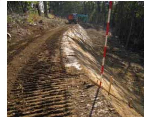
林業専用道新設工事
