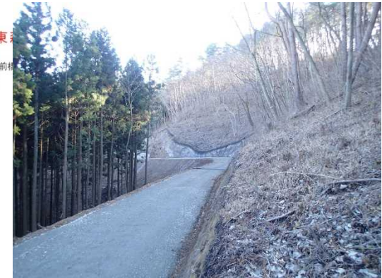
林業専用道の新設
