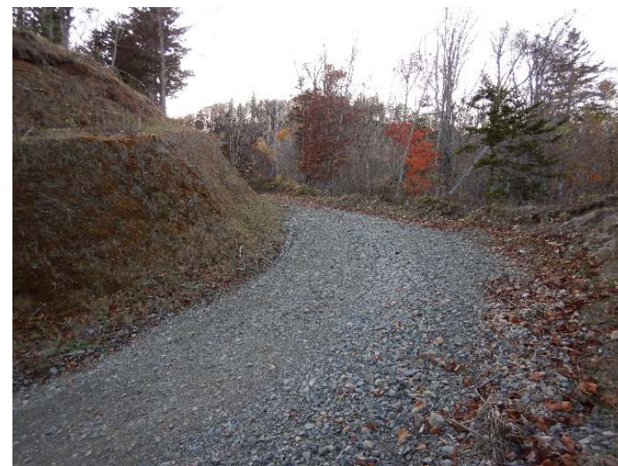
カンカン林道 新設工事
