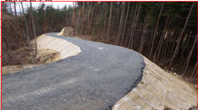
丹波楯山林業専用道新設工事 村松国有林
