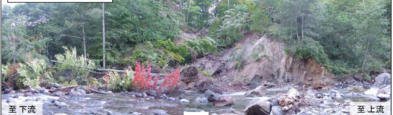
末端部の溪岸崩壊状況
