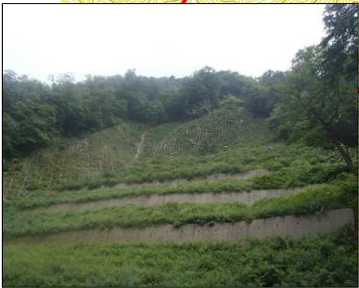
大ツゲ谷区域 山腹工
