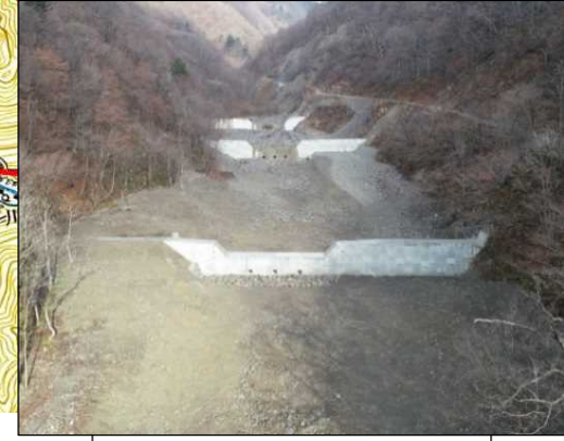
海ノ溝谷区域 溪間工
