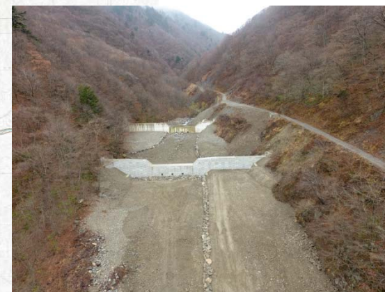
海ノ溝谷区域 溪間工 (施工後)
