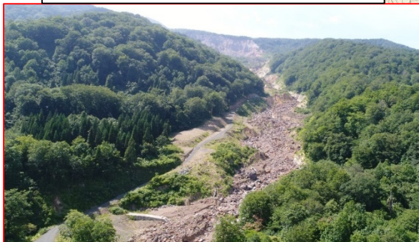
産女川上流の荒廃状況(上空から)
