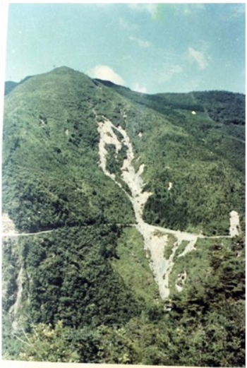
崩壊発生当時
