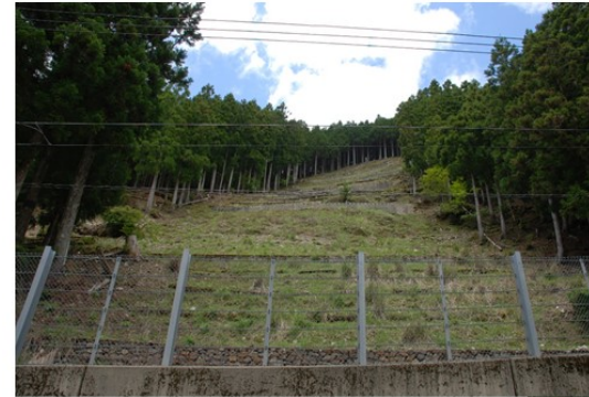
現在(山腹施工箇所)
