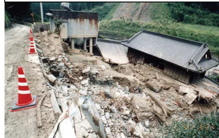
被災状況:川上区域内人家
