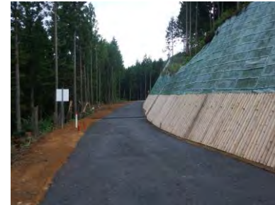
林道の新設 (関東森林局福島森林管理署白河支署)
