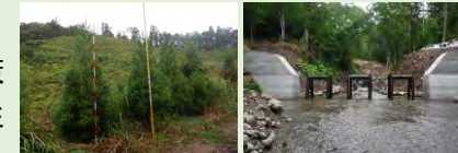
成長のよい特定苗木 流木捕捉式治山ダム工
