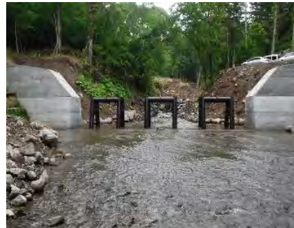
流木捕捉式治山ダム工
