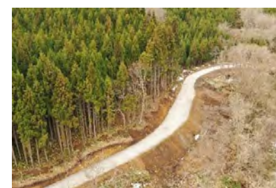
走行車両の大型化に対応した路網の改良 (東北森林管理局三八上北森林管理署)
