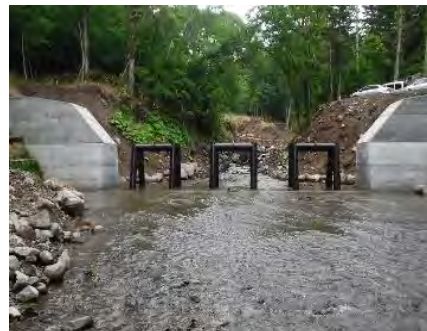
流木捕捉式治山ダム工
