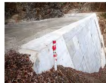
擁壁工の改良による 路網の強靱化・長寿命化 (近畿中国森林管理局三重森林管理署)
