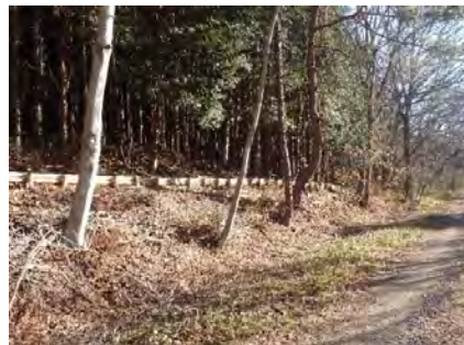
避難指示解除区域における里山再生事業 による除伐及び丸太筋工 (関東森林管理局磐城森林管理署)
