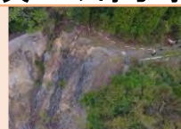
ドローンを活用した被災状況調査
