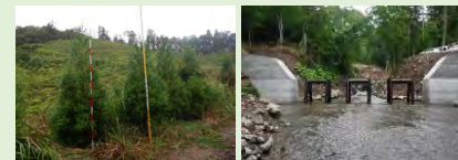
成長のよい特定苗木 流木捕捉式治山ダム工
