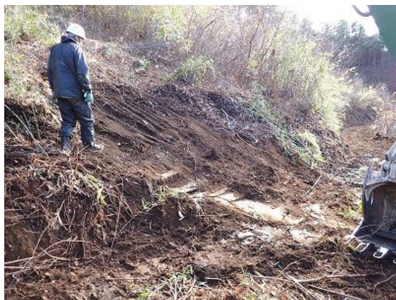
作業道上側の段になっている箇所をグラップルで均し、多目的造林作業機が斜面に侵入。
