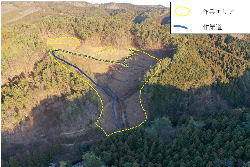
写真 5-1 人力地拵えの実施エリア
