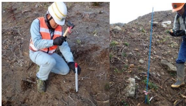
写真 3-1 L杭(左)及びFRPポール(右)の設置状況
