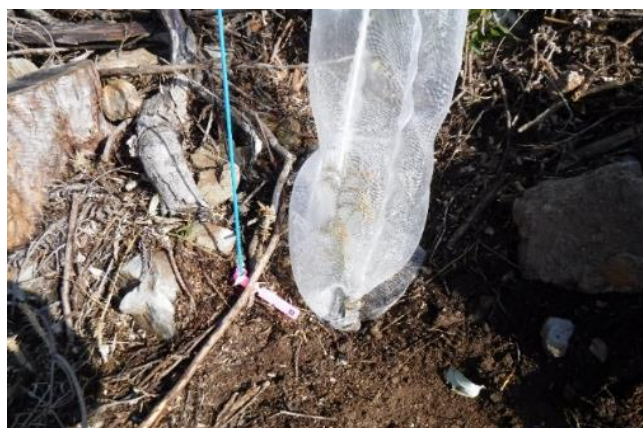
写真 3-79 単木保護ネットの設置状況（令和2（2020）年2月）
