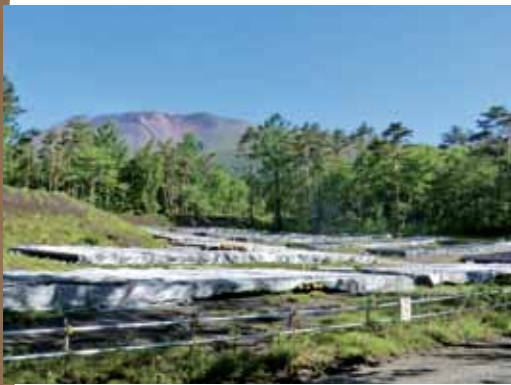
写真4 遮光シートで保護し養生する様子
