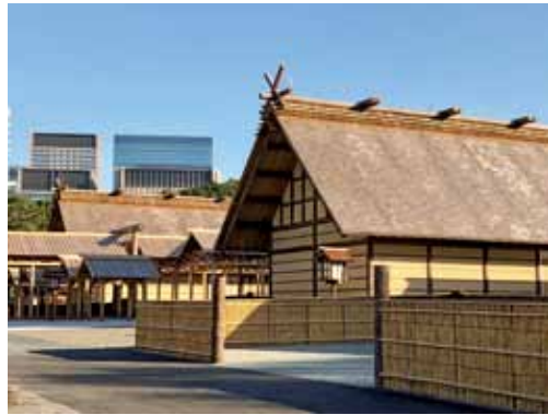
写真1 完成した大嘗宮
