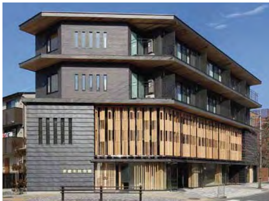
日本初の木現し2時間耐火部材を用いた純木造4階建てビル
