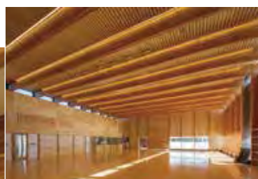
日本初の木現し2時間耐火部材を用いた純木造4階建てビル
