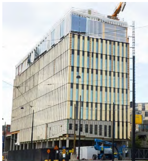
写真 6.1 建設中の木造マンション
