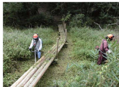
歩道の整備状況
