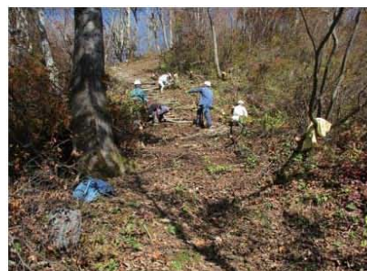
歩道での階段づくり作業
