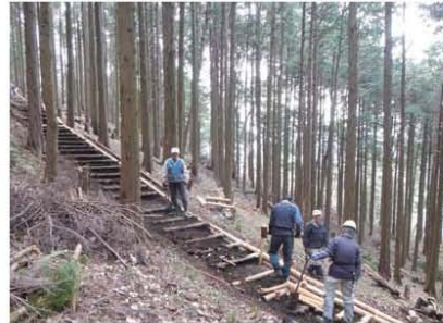
歩道の補修作業
