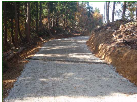
林道（林業専用道）新設
