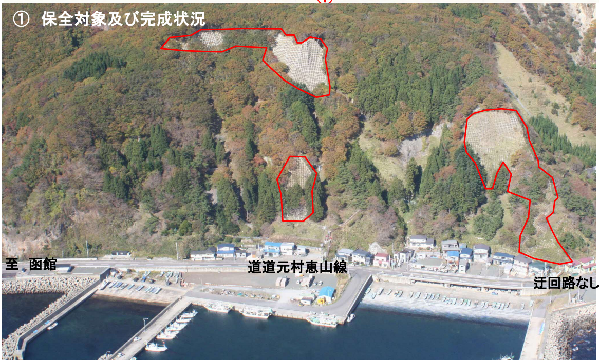
② 施工前状況
