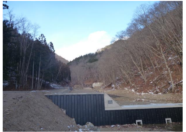
完成した谷止工
