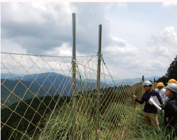
ネット継ぎ目と施工状況
