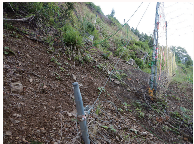
テンション機材と施工状況
