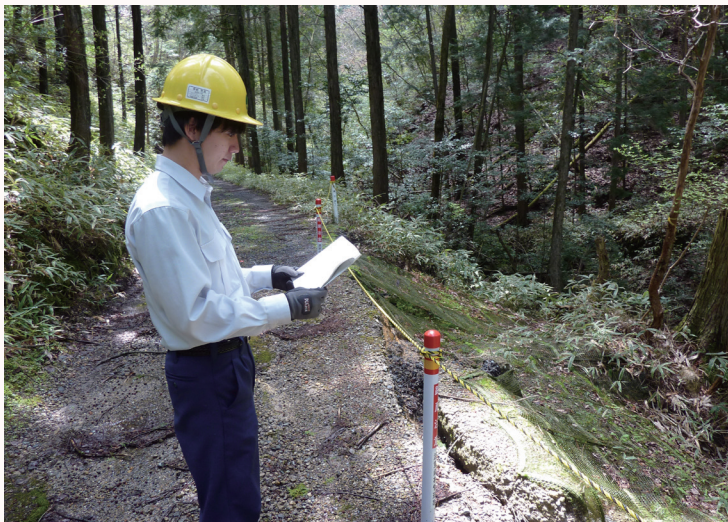
崩壊地（事業地）の確認中
