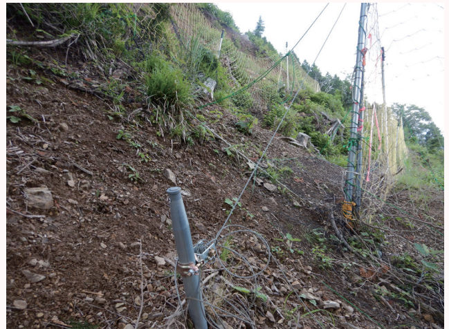
テンション機材と施工状況
