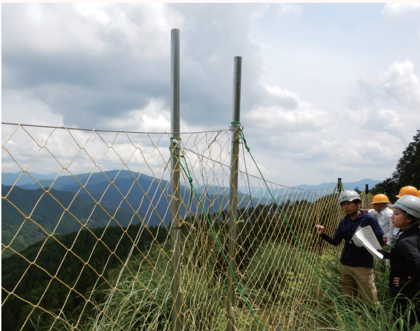
ネット継ぎ目と施工状況
