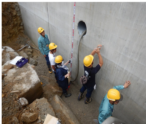
コンクリート強度の測定
