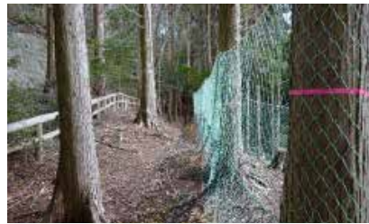
立木を活用した防護柵
