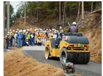
簡易舗装材利用の路網作設検討会の様子 三重県いなべ市 悟入谷国有林
