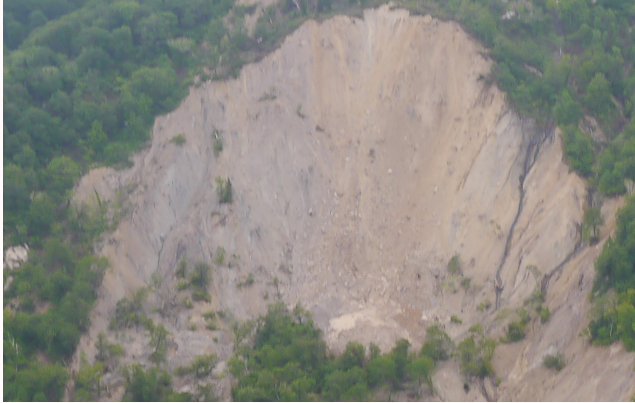
崩壊地の状況（平成 27 年 6 月）
