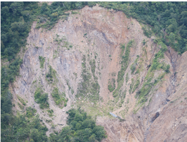
崩壊地の復旧状況（令和 2 年 9 月）
