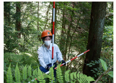
国有林内で林道測量のOJT中
