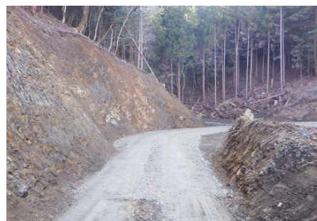
新設された林道
