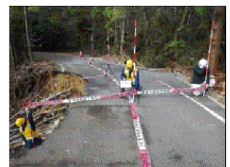
災害箇所の現地調査
