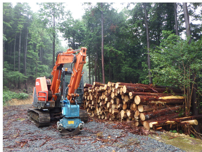
搬出された作業道の支障木
