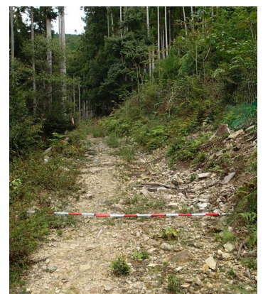
試験を行った森林作業道
