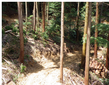
作設された作業道
