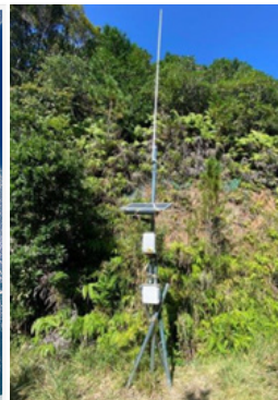
親機の設置状況
