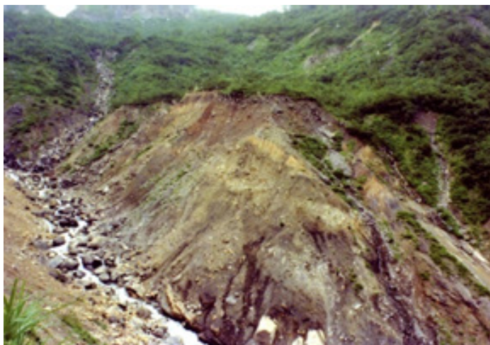
対策工施工前・昭和59年(1984)
