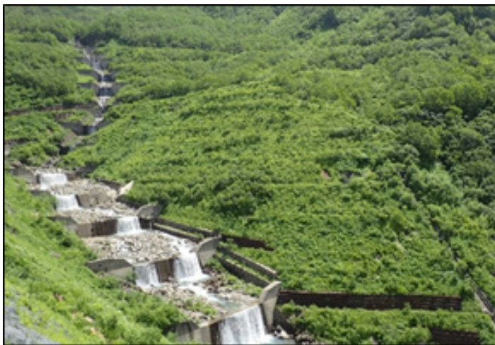
対策工施工後・令和2年(2021)
