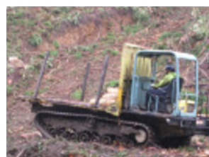
フォワーダによりコンテナ苗等を運搬
