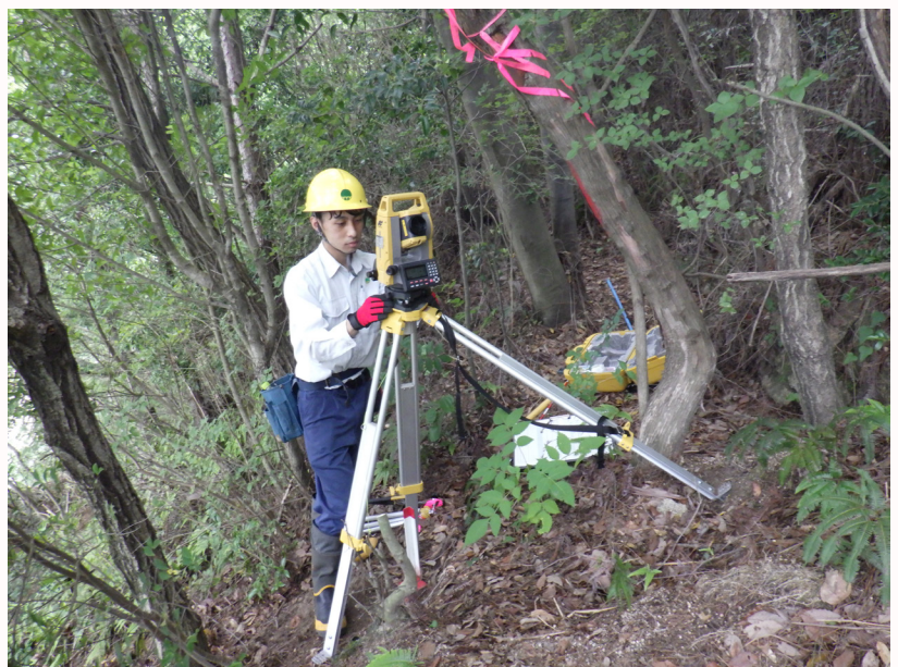
トランシットを使用した測量の様子
