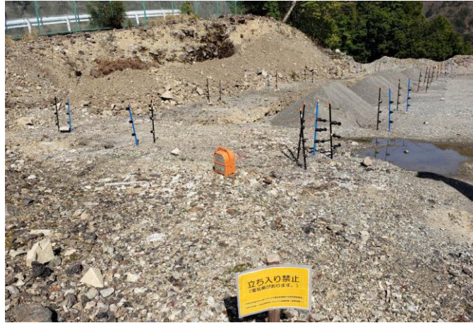
図 3-10 電気柵とアース用ワイヤーメッシュの設置
