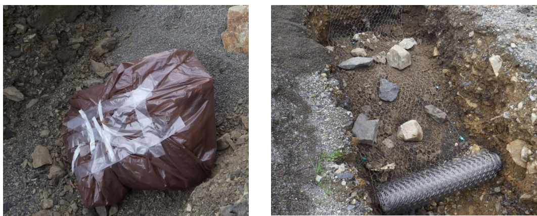
図 3-9 生分解性ガスバリアシート(左)とワイヤーメッシュを使用した埋設 (右)
