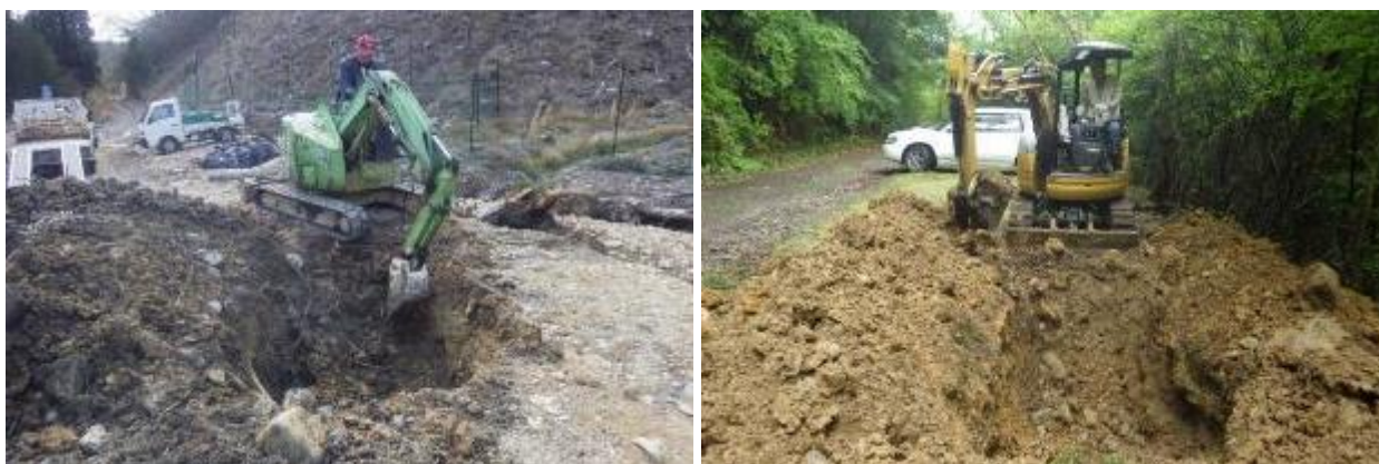
写真8. 埋設穴の掘削作業の様子
