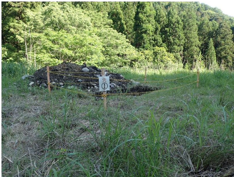
写真 19 埋設穴の安全対策措置（穴 1）
