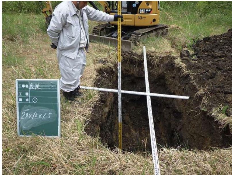
写真 18 埋設穴の掘削状況（縦 2m×幅 1m×深さ 1.5m、穴 1）
