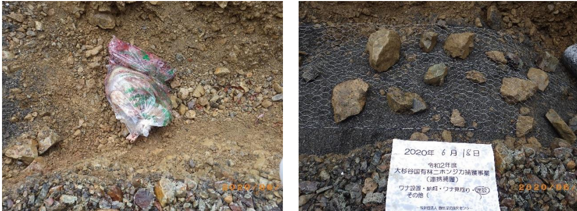
図 3-10 生分解性プラスチック袋、ワイヤーメッシュを使用した埋設
