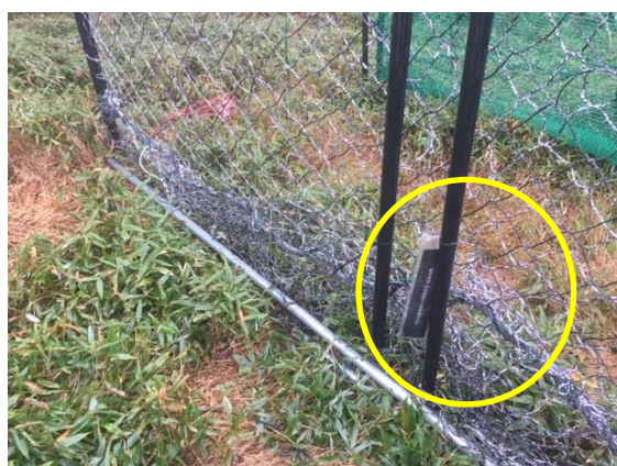
図 3-1 法令上定められた標識の取り付け
