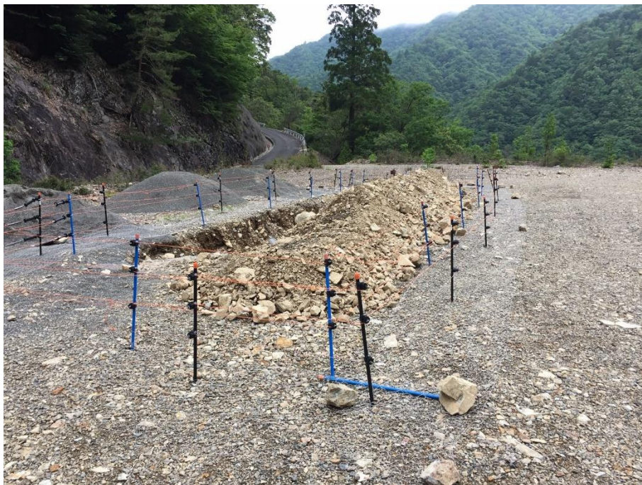
図 3-11 電気柵とアース用ワイヤーメッシュの設置
