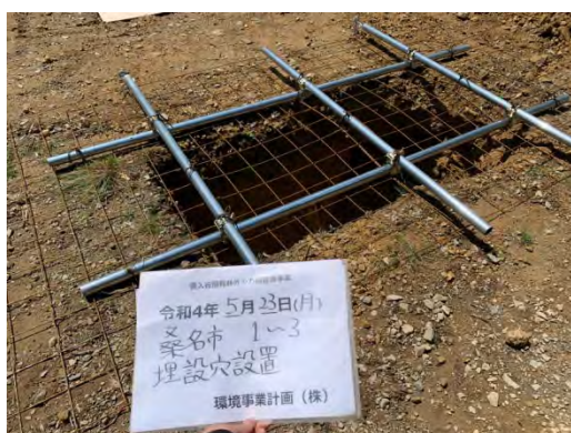
ワイヤーメッシュ等によるふた 単管で枠を組み、ワイヤーメッシュを設置する。各穴を小さく掘削することで、小さく頑丈なふたの設置を行った。
