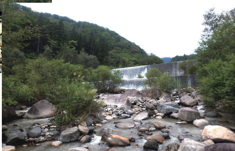
施工後の状況(令和元年)
