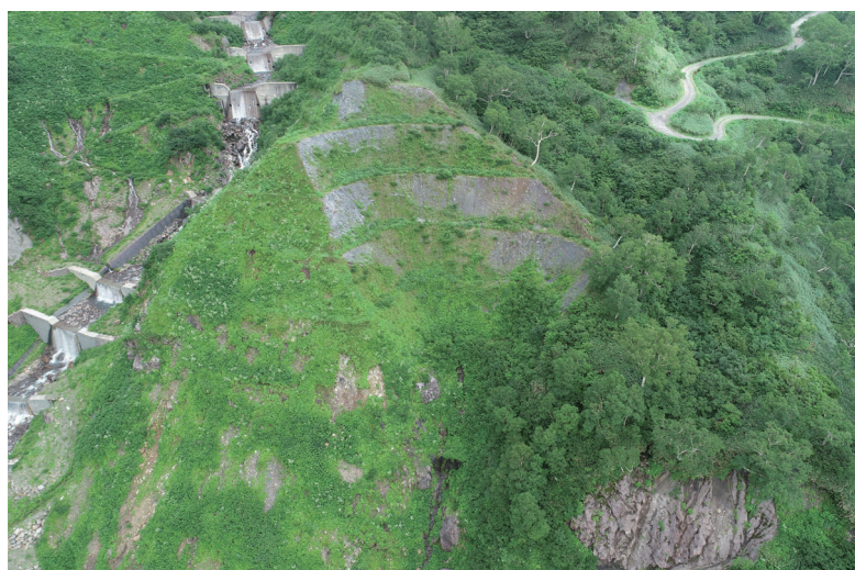
山腹工の施工（ホ-13-2崩壊地）
