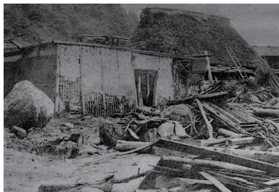
家屋の被害状況
