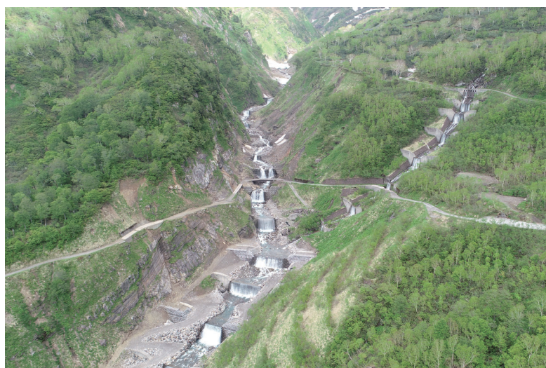
溪間工の施工（本流第23号～32号）
