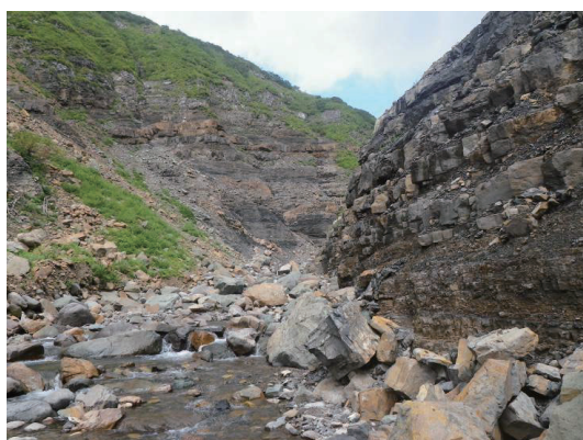
溪流の荒廃状況
