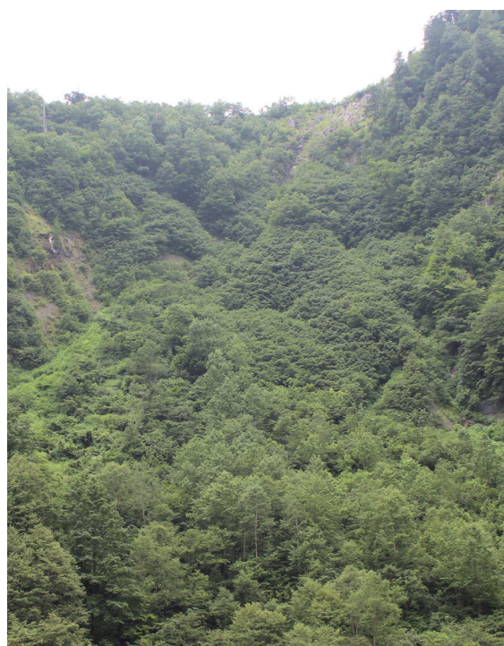
現在の状況(令和4年)
