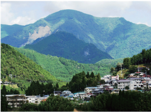
谷瀬の吊橋・上野地集落と濁谷崩壊地
