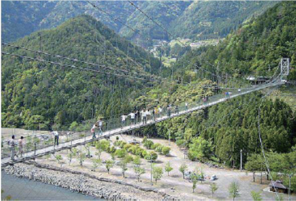
谷瀬の吊り橋
