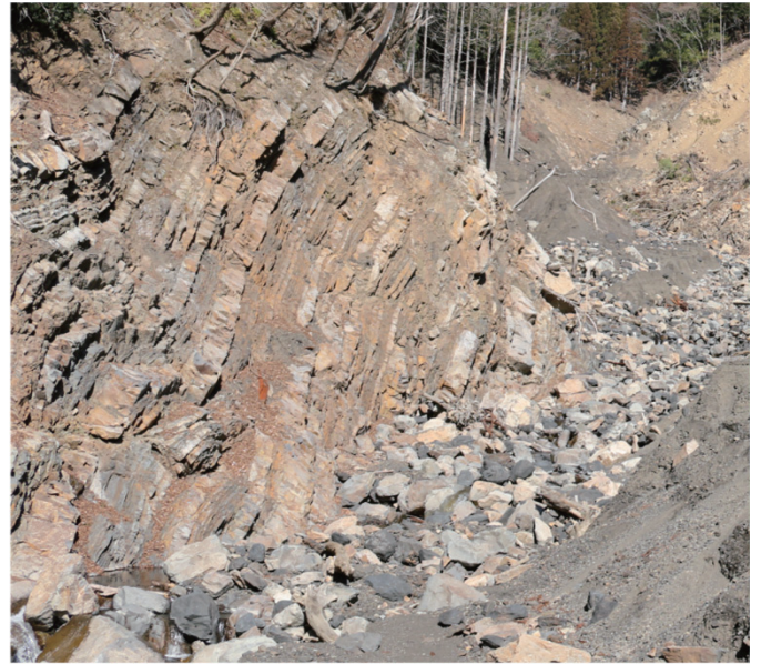
破碎された脆弱な地質の状況 (今西にて撮影)
