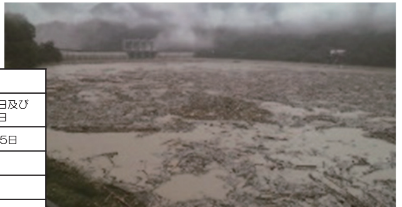
台風12号による流木の堆積状況（風屋ダム） （平成23年9月撮影）
