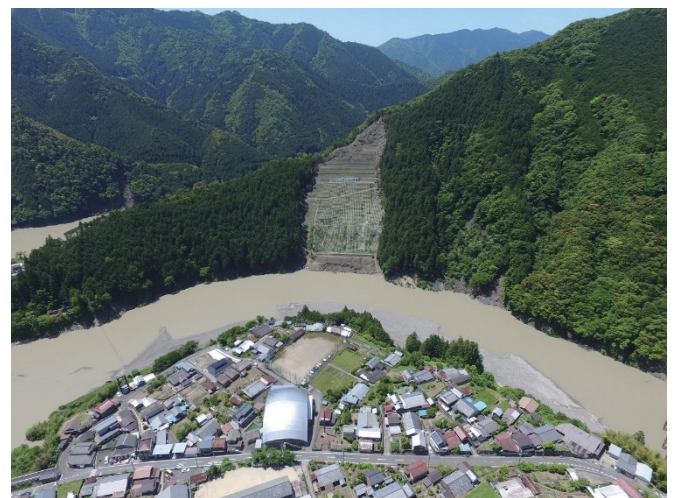
折立崩壊地と集落 ※工事が完成し、下流域を保全（H27完成）
