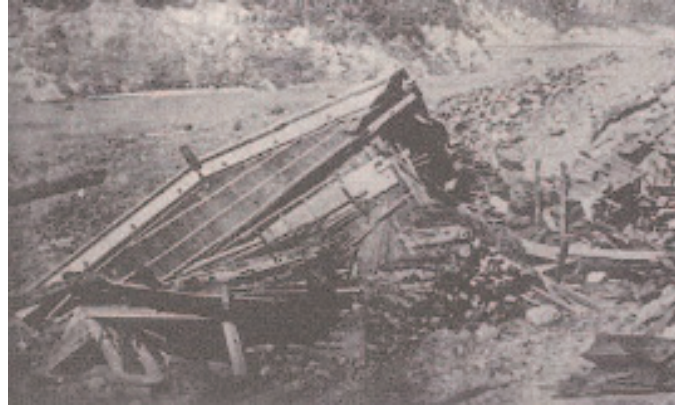
家屋の被災状況
