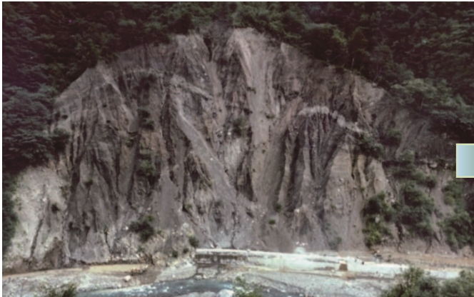
施工前の荒廃状況（昭和46年撮影）
