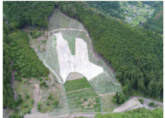
上野地区区域：高津谷㊟-2 山腹工 2.67ha
