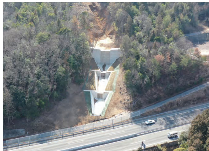
流路工 (写真下部は山陽自動車道)
