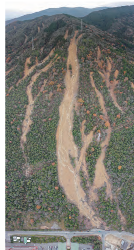
黒瀬区域(東広島市)で発生した山地災害(遠景)
