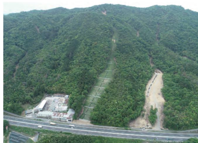
山腹工 (写真下部は山陽自動車道)
